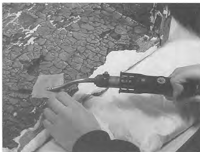
写真25 剥落処理（塗膜圧着）
