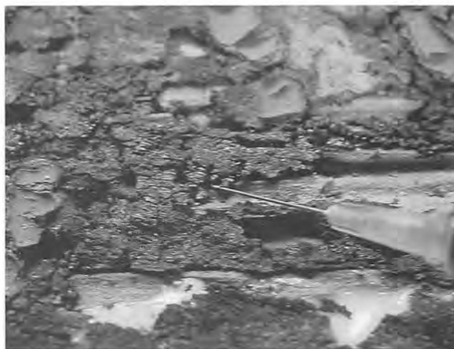
写真24 剥落処理（兎膠を注入）
