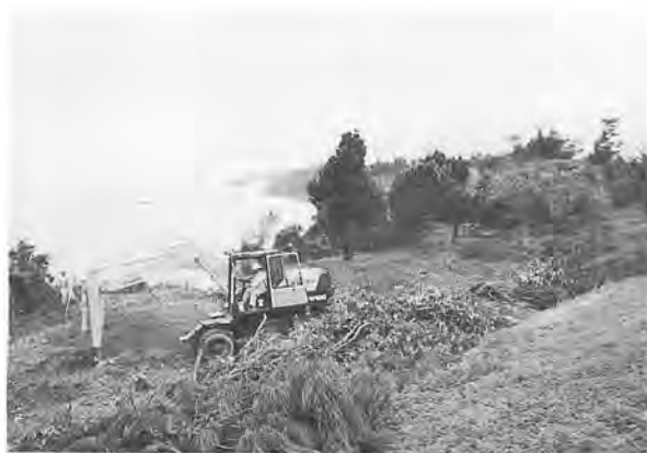
写真19. 長根原遺跡試掘調査状況
