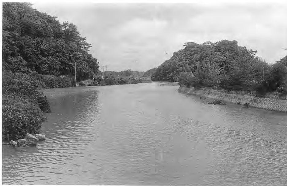
大井川下流のアマンガー付近
