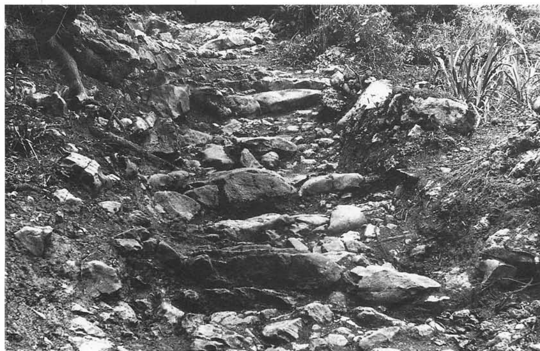
P L . 26 旧 道 の 石 段 、 北 側 よ り
