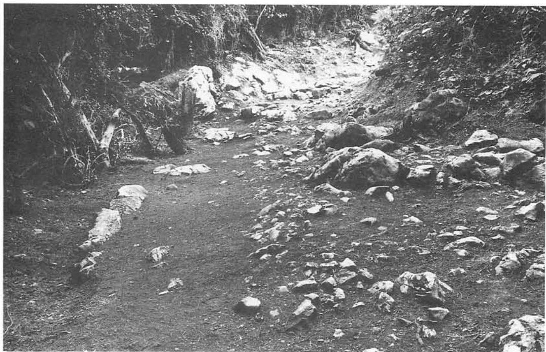
P L . 27 旧道の縁石、北側より
