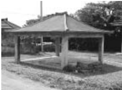
▲コンクリート屋根の神ハサギ(平成10年)
