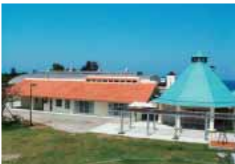
▲新築されたクラブハウス
