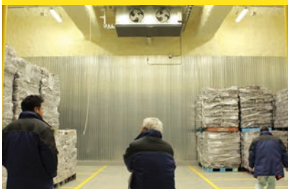
▲平成30年12月20日から稼働、今帰仁冷凍冷蔵施設(冷凍庫)・運天港内
