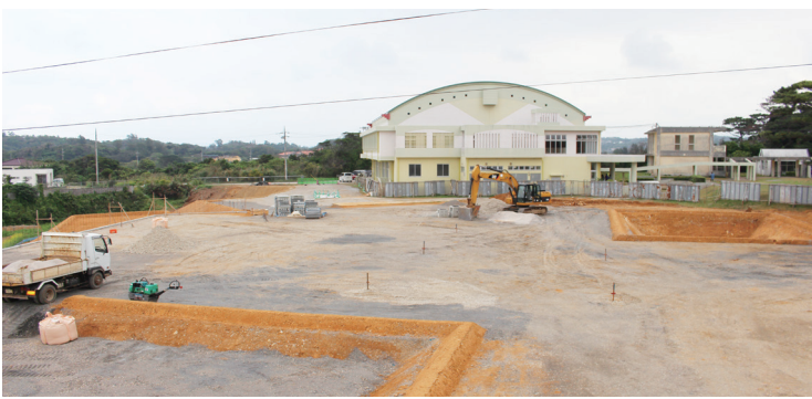
▲認定こども園造成工事現場
