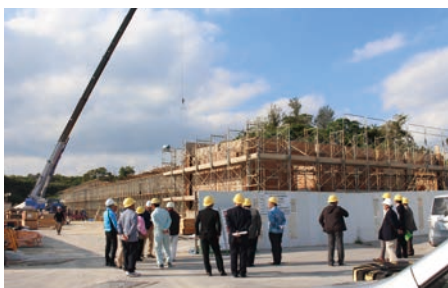
▲今帰仁冷凍冷蔵施設整備工事（運天港内）
