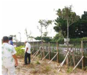
▲今帰仁城跡周辺環境整備 今泊港川改修工事（3工区）
