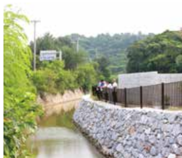
▲今泊港川改修工事（4工区） 湾岸工
