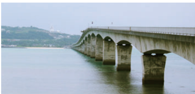
▲平成17年に開通した古宇利大橋を光ファイバーケーブルのかけ橋に
