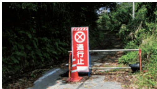
▲長期通行止めになったままの崩落部位 (通称マッチャク)
