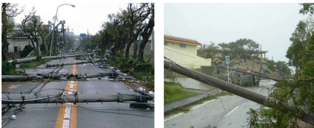
写真－1 台風による電柱倒壊状況
