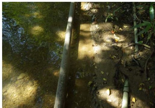
地点 5 (右岸) 赤土の堆積あり
