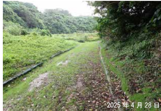
洗掘3（旧道路。洗掘補修後に種子吹付け）
