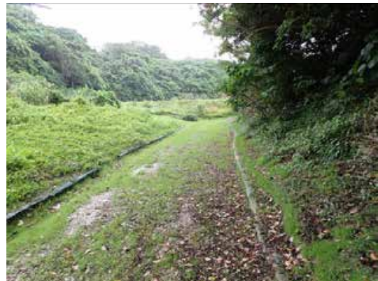
旧道路の洗掘箇所における補修後の状況
