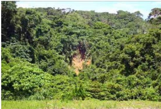
崩落2（流域の自然斜面の崩落）
