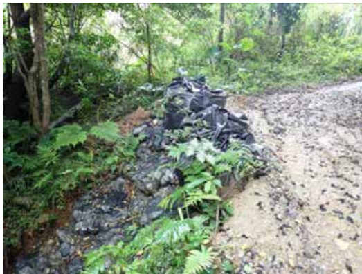
旧管理用道路における洗掘箇所の整備後の状況
