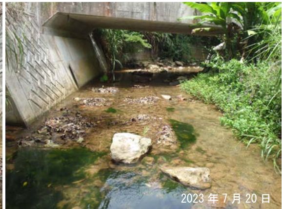
整備後_橋梁直下の淵はほとんど消失 （上の写真と同じ場所：下流側から橋梁方向へ撮影）
