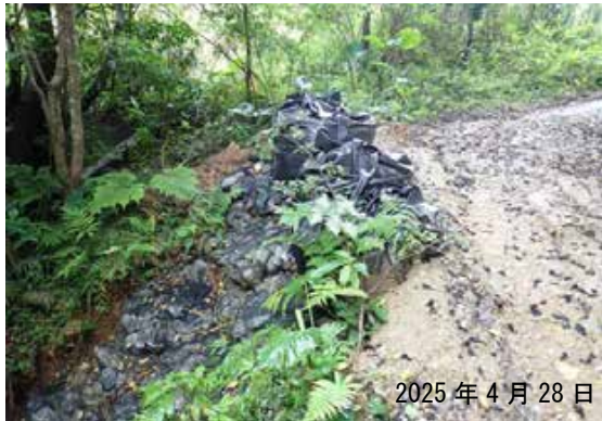
洗掘2（旧管理用道路脇。洗掘補修後：道路脇から撮影）
