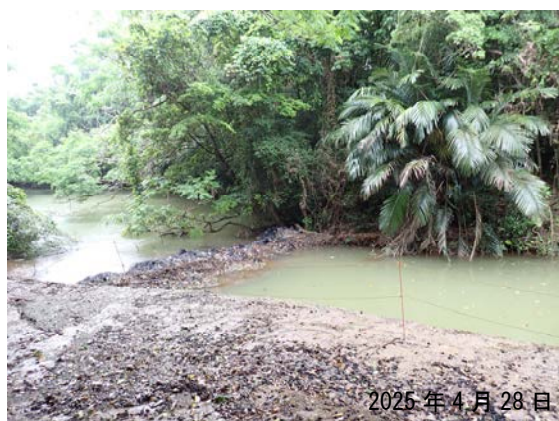
撮影地点⑤：北西側付近（調整池 A: 浚渫後の状況）
