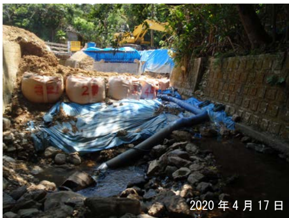
工事中_橋梁の上流側の状況 （流水をポンプで下流へと迂回させている）
