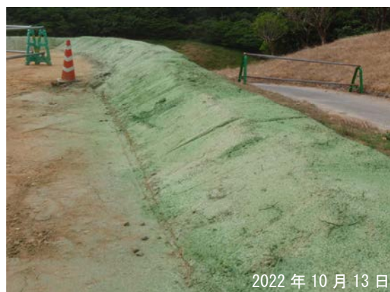
流出抑制工（小堤工）
