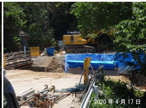
工事中_橋梁周辺の状況 （橋梁周辺の護岸整備）
