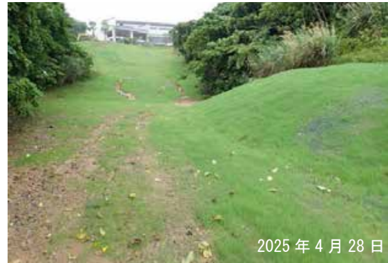
洗掘5（旧道路の洗掘を補修後に種子吹付け）
