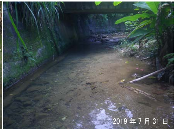
整備前_橋梁直下の淵（上流側に向かって撮影）
