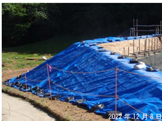
仮表土保護工（シート被覆）
