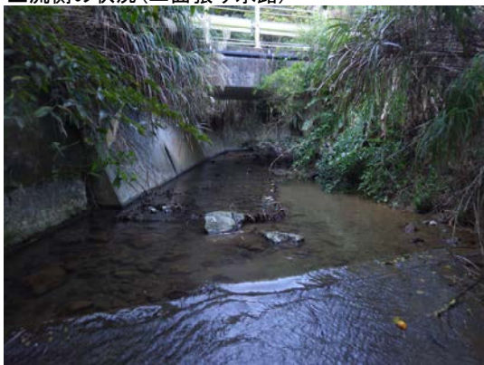
下流側の状況（橋梁付近）
