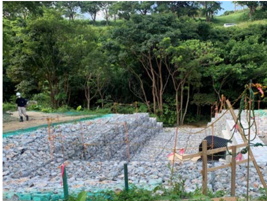
旧排水路流末における崩落箇所の整備後の状況
