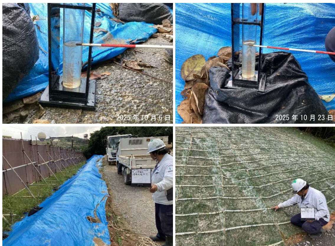
図 4-12 施工業者による水の濁り監視状況及び場内巡視状況
