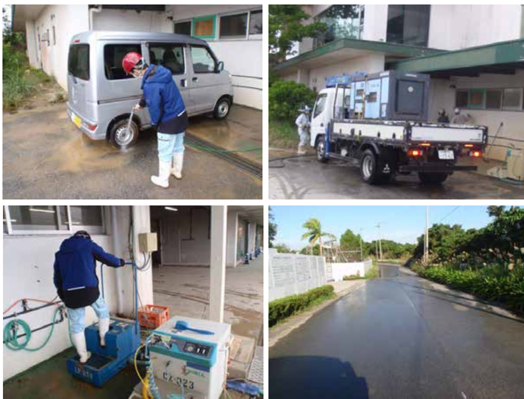
図 4-6 粉じん対策状況（車両のタイヤ・作業員長靴の洗浄・散水）
