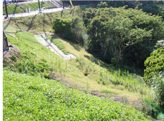
北東側の法面洗掘箇所における整備後の状況
