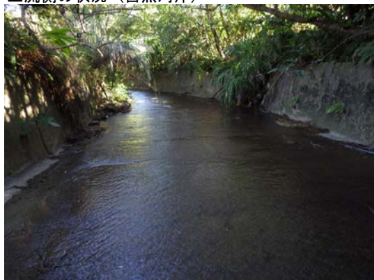
下流側の状況（三面張り水路）
