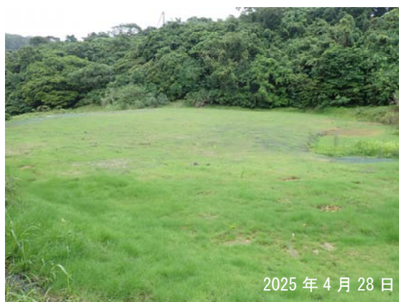
撮影地点④：北西側付近（4号濁水貯留施設：撤去跡）
