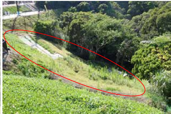
洗掘1（2023年度の台風による洗掘における整備後の状況）
