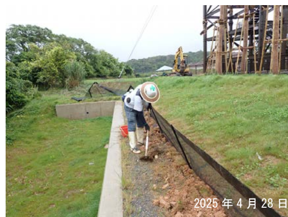
撮影地点①：北西側付近の状況（ハブネット敷設）
