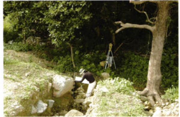
6. 根石確認トレンチ⑨測量作業状況
