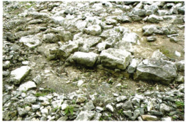
2. U-V 外壁検出状況
