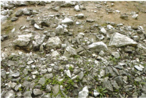
3. W-X 外壁検出状況
