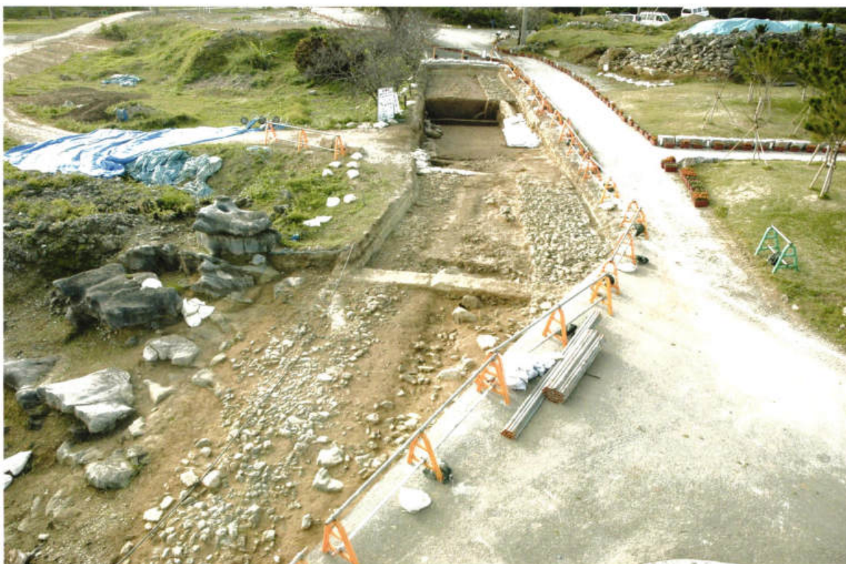
3. 1 2次外郭調査完了状況
