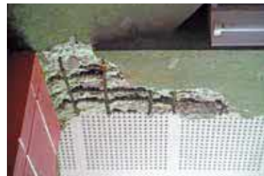
梁の補修工事箇所
