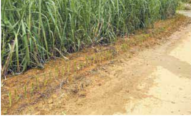
【対策事例】赤土流出を防ぐベチパーの植栽
