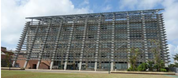
◀外壁を太陽光発電パネルの格子で包み、建物への熱負荷の低減と自然エネルギーの活用を行っている（糸満市庁舎）
