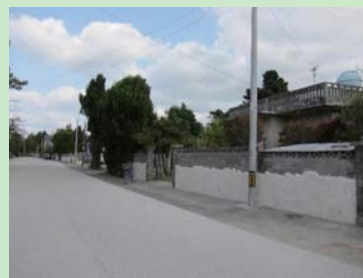
集落内の沿道景観を向上させる琉球石灰岩のブロック塀
