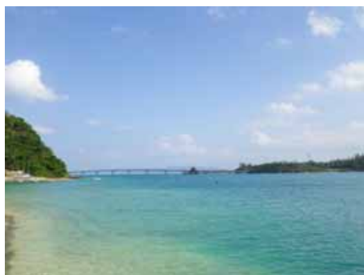
運天港より古宇利大橋を望む
