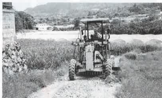
▶ 与那嶺区の農道を補修するグレーダー
