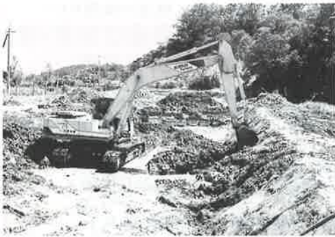
▲工事が始まった湧川前田原地区
