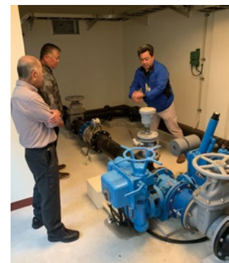
▲水道施設の現場踏査の様子
