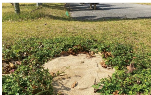
▲運動公園内くぼみ(補修後)
