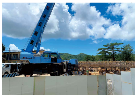
今帰仁小学校新校舎工事
