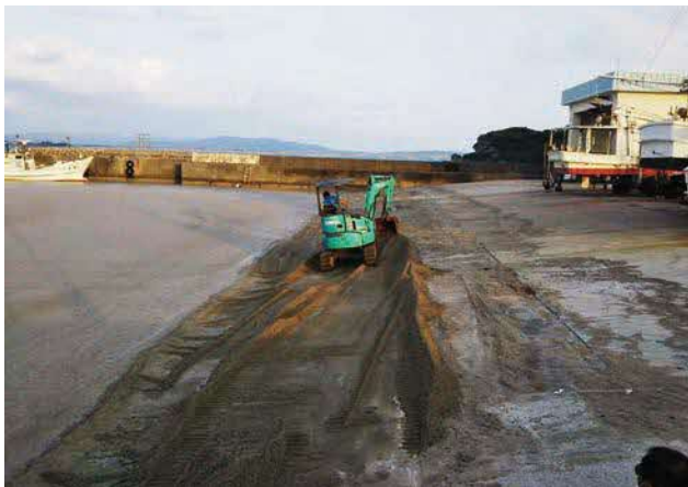
今帰仁漁港スロープに打ち上げられた軽石の除去作業
