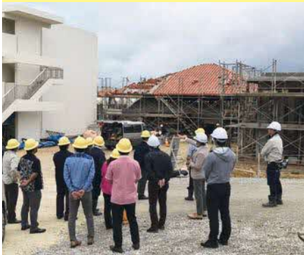
古宇利小中学校跡地ホテル建設現場
