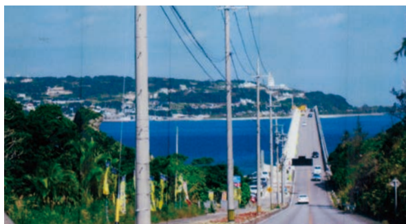
県道 247号古宇利島屋我地線から眺める古宇利大橋
