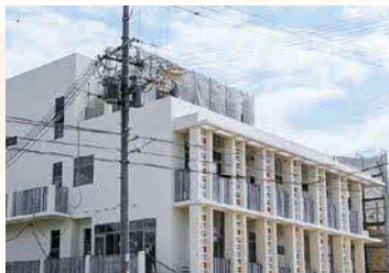
令和4年10月26日撮影(新庁舎外観)
