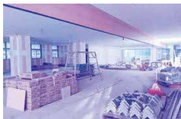
令和4年9月21日撮影(新庁舎1階フロア)
