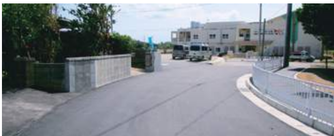
村道越地与比地小浜原線道路改良工事
