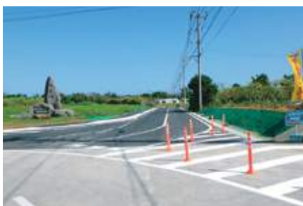
村道与那嶺線道路改良工事
