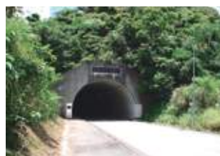
呉我山トンネル
