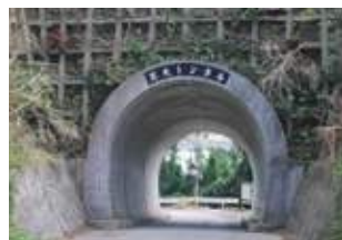
運天トンネル
