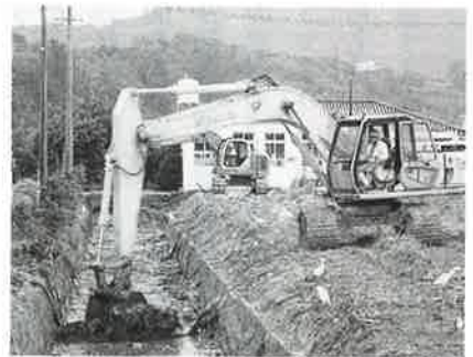
▲排水路浚渫工事
