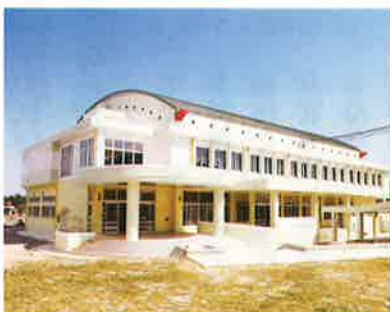
▲平成12年度に簡保資金の融資を受け完成した今帰仁小体育館
