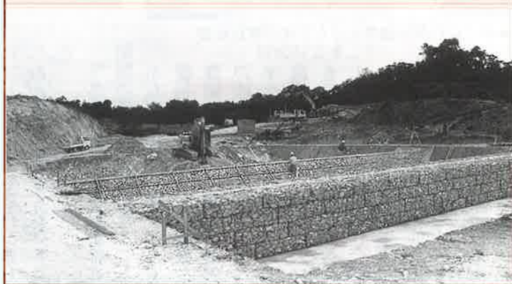
▲着々と工事が進められる村立統合中学校建設現場
