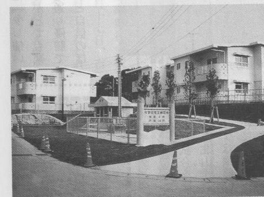
▲村営住宅玉城団地建築工事
