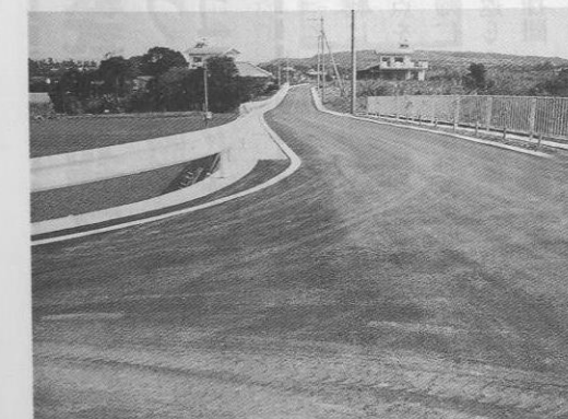
▲上運天唐の森線道路改良工事
