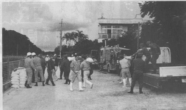
▼災害を想定し積み土の工法で堤防の補強作業をする消防団員ら
