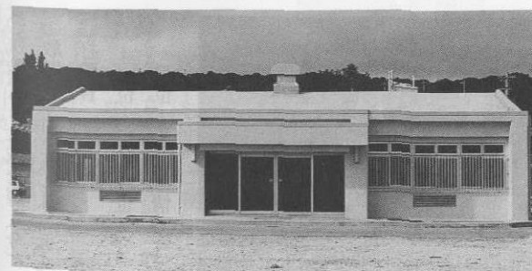
△完成したばかりの漁具倉庫・水産物処理施設
