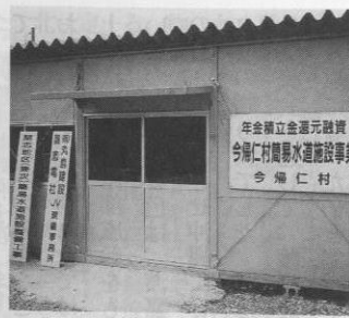
▲諸志地区(兼次)簡易水道施設整備工事
