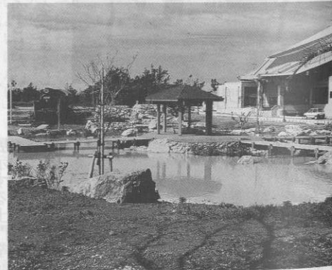
▲ふれあい広場池、流れ工事
