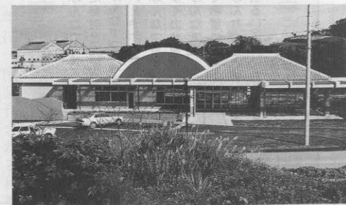
▲中山間活性化施設工事「今帰仁の駅」そーれ
