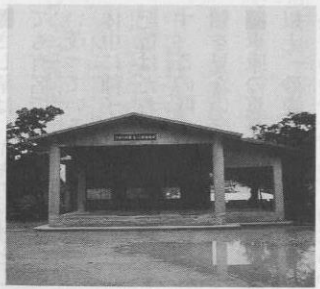
▲完成した屋外ステージ
