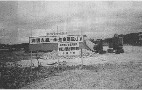
▲諸志地区簡易水道施設整備工事
