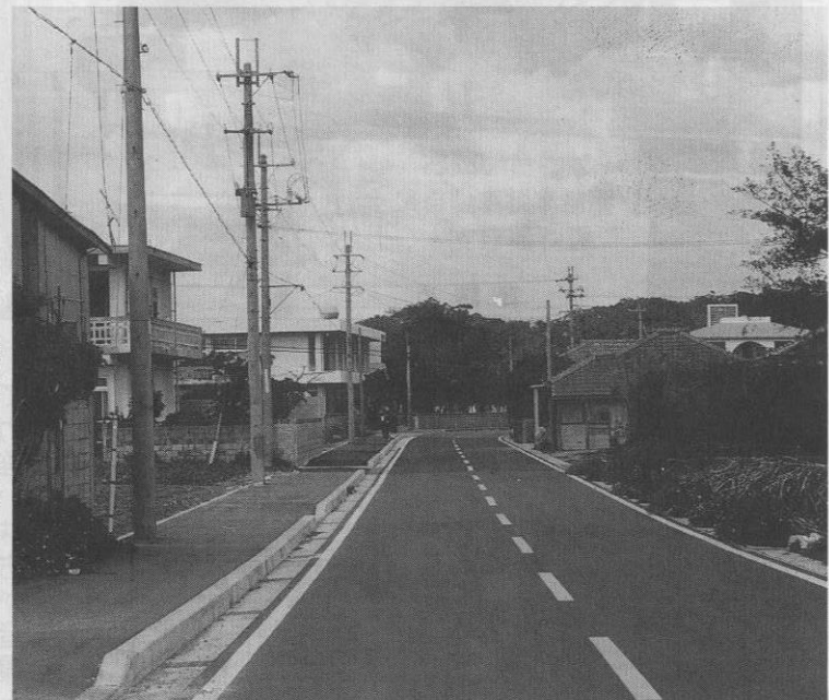
▲仲宗根運天線道路改良。歩道も整備され、交通安全に一役
