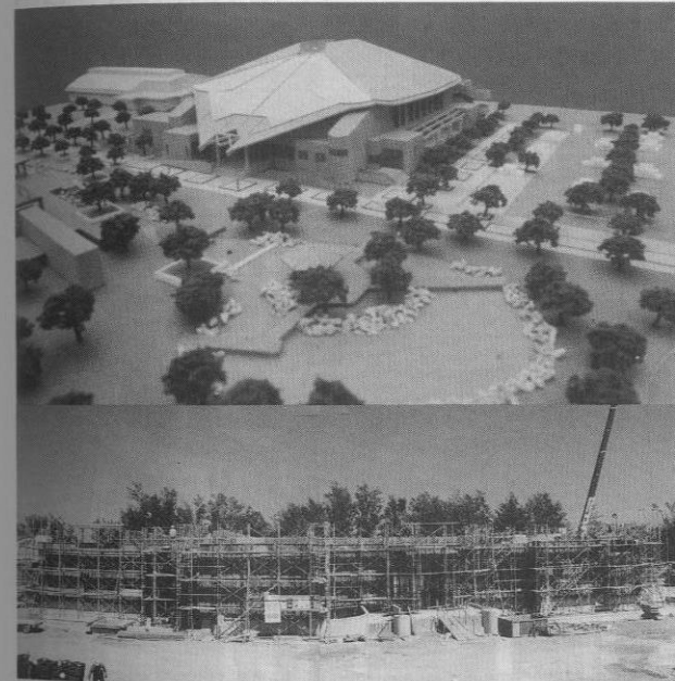
▲屋内スポーツ広場完成予想写真(上)急ピッチで工事が進む(下)
