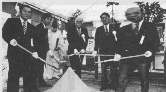
▲工事の安全を祈願し、クワ入れを行う上間博安村長(中)客席。なお、完成は平成九年六月の予定。
