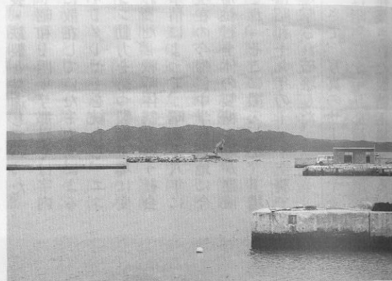
▲運天漁港局部改良工事。
