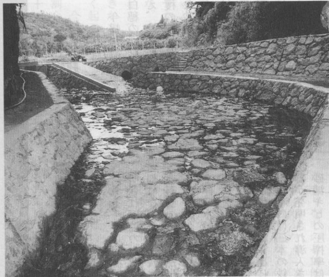
▲部分により自然石を利用した、謝名地区幹線排水路。
