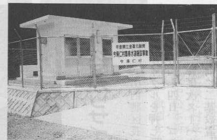
▲完成した湧川地区水道施設
