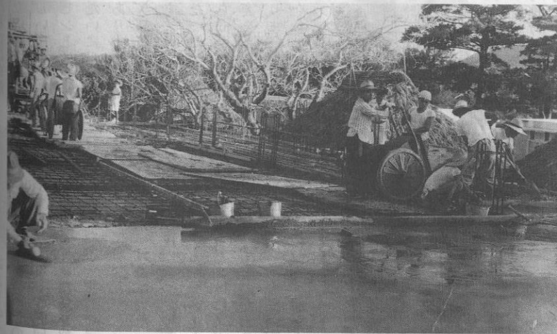
▲今帰仁小学校のスラブ打ち現場(1955年10月)
