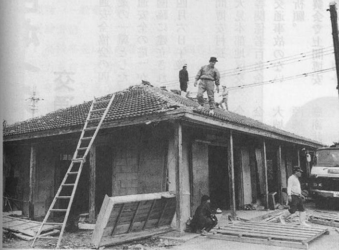
▲旧公民館の取り壊し作業 (1993年3月)
