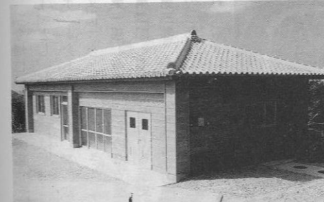
乙羽岳総合案内施設管理棟新築工事
