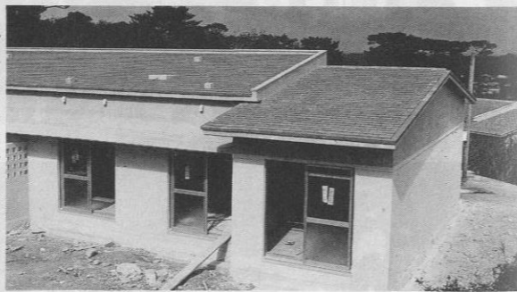
▶ 勢理客第二団地新築建築工事
