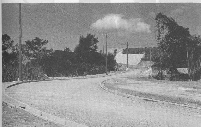
▲湧川線道路改良工事
