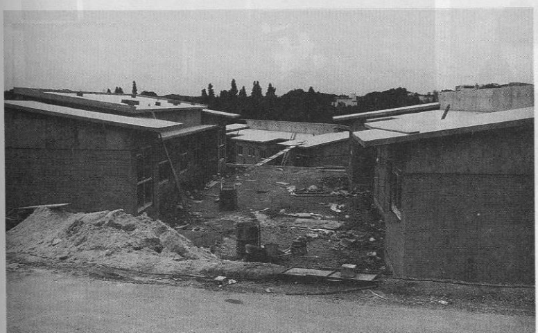
▲着々と工事が進められる与那嶺団地
