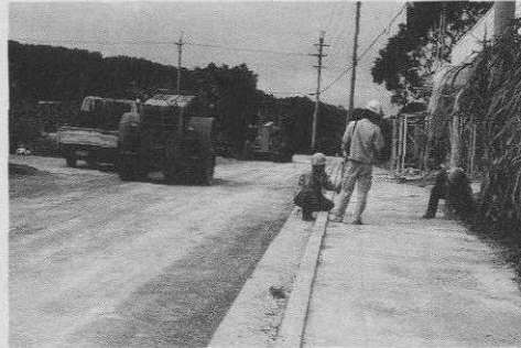
▲謝名上手名線舗装工事
