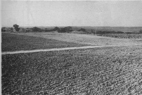
▲今泊土地改良工事
