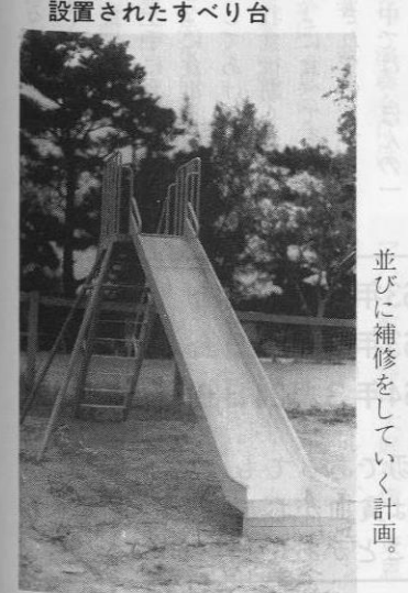
設置されたすべり台
