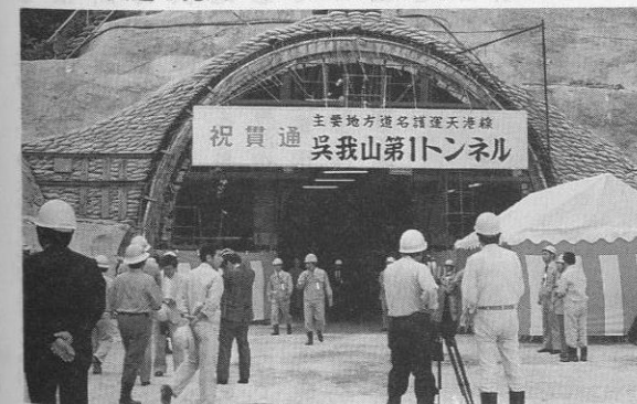
▼貫通し完成がまつれる呉我山第1トンネル
