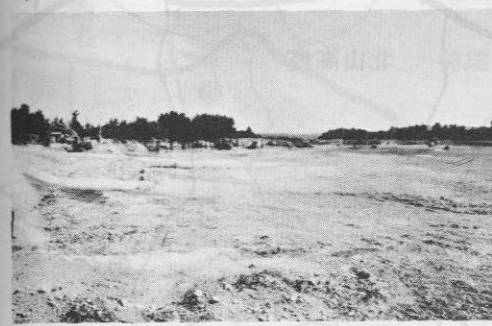
工事中の村民運動場
